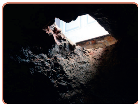
Puits d'accès à l'effondrement sous le porche de la maison.
