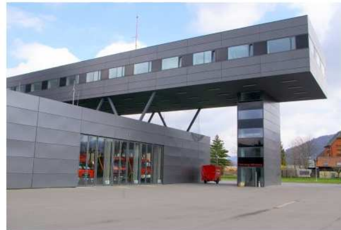
Caserne PASSIVE des pompiers de Heidelberg (Allemagne)
